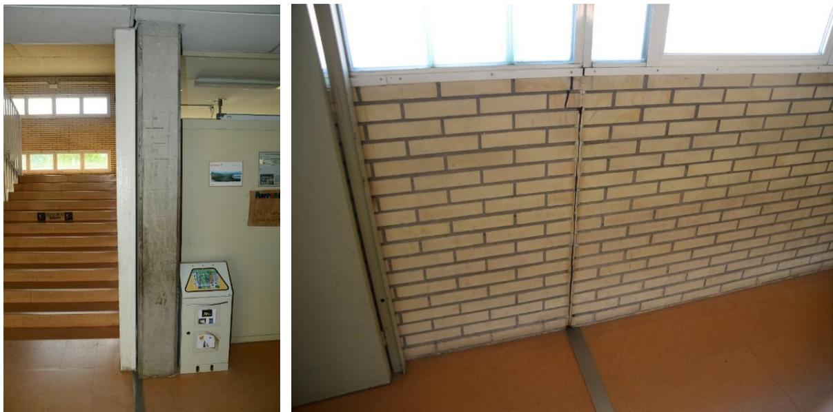
**Figura 20. Detalle de la junta de dilatación que separa las estructuras de los edificios 'A' y 'B' del Instituto Santa Eugenia.**
