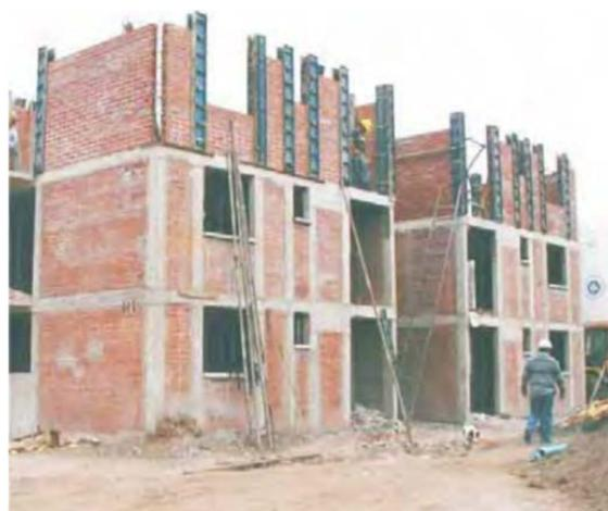
Figura 4-10. Ejemplo de muro reforzados globalmente.
