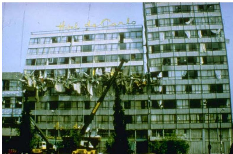
Figura 3-5. Daños por falta de espaciado en la junta. Terremoto de México 1985. Fuente: [http://www.johnmartin.com/earthquakes/eqshow/647003\\_08.htm](http://www.johnmartin.com/earthquakes/eqshow/647003_08.htm)
