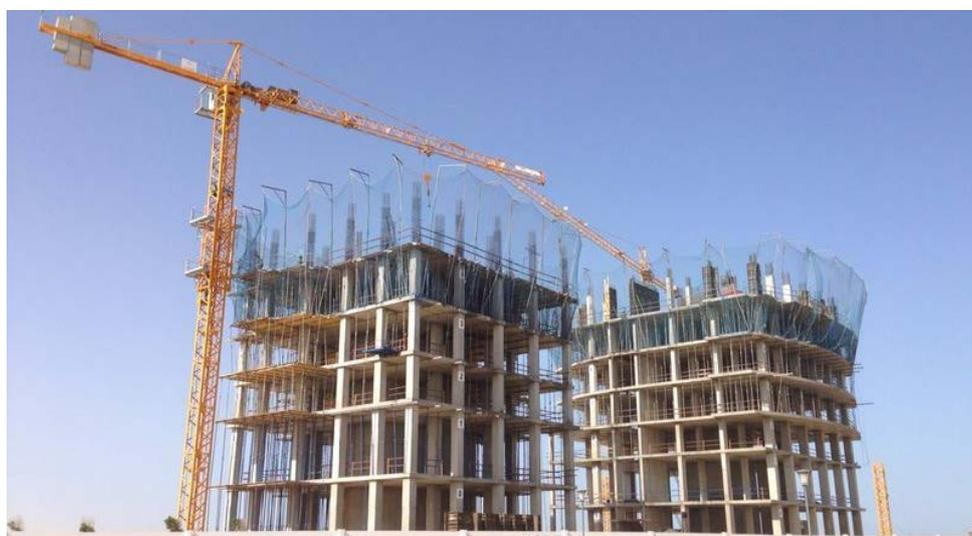
*Figura 4-11. Ejemplo de edificios de hormigón armado en construcción.
