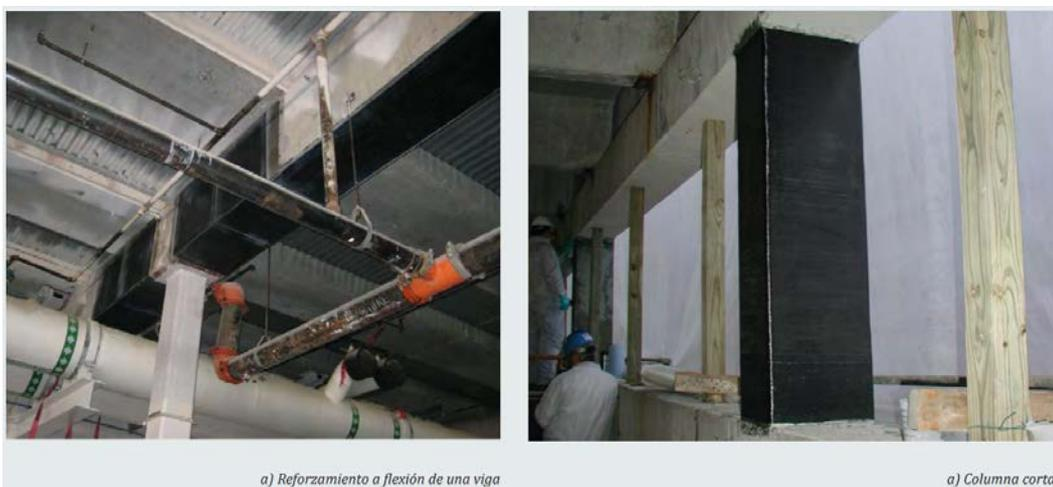
Figura 6-3. Refuerzos con tejidos de polímero reforzado con fibra (FRP): a) a flexión y cortante, b) a flexión, cortante y confinamiento a compresión. Fuente: (Alcocer and Murià, 2021).
