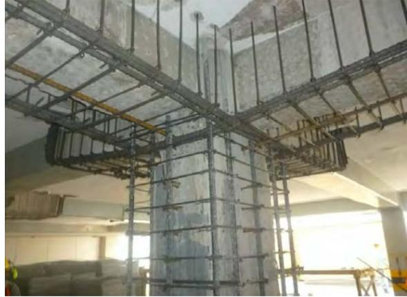
Figura 6-15. Refuerzo de un nudo mediante encamisado de (a) fibras de carbono (b) de hormigón armado.
