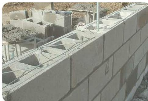
Figura 4-8. Imágenes de muros de fábrica armada.
