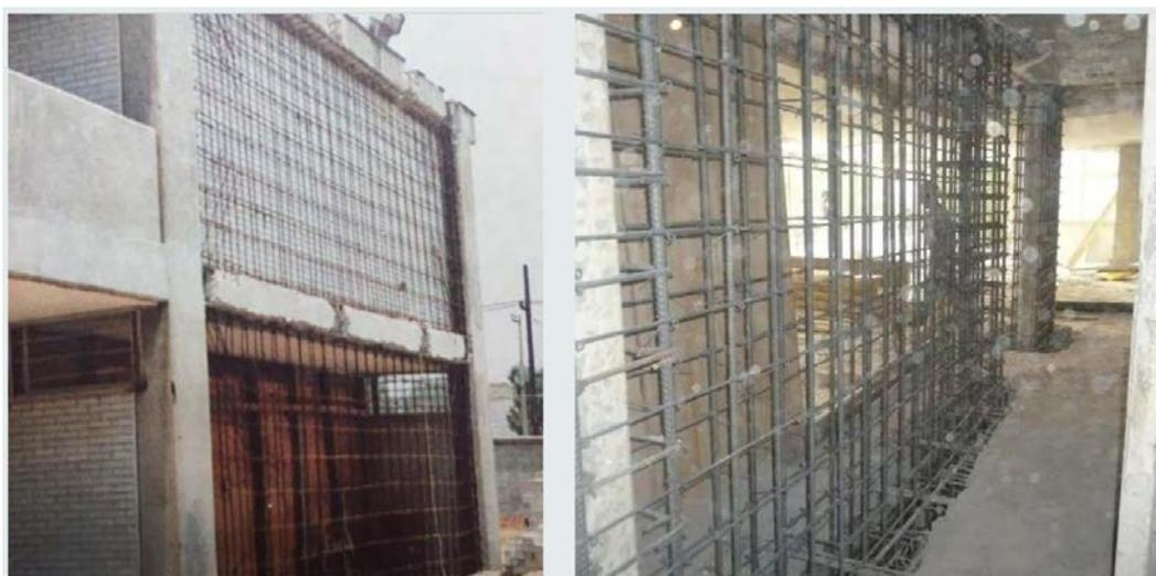
*Figura 6-7. Rigidización mediante nuevos muros de cortante.
