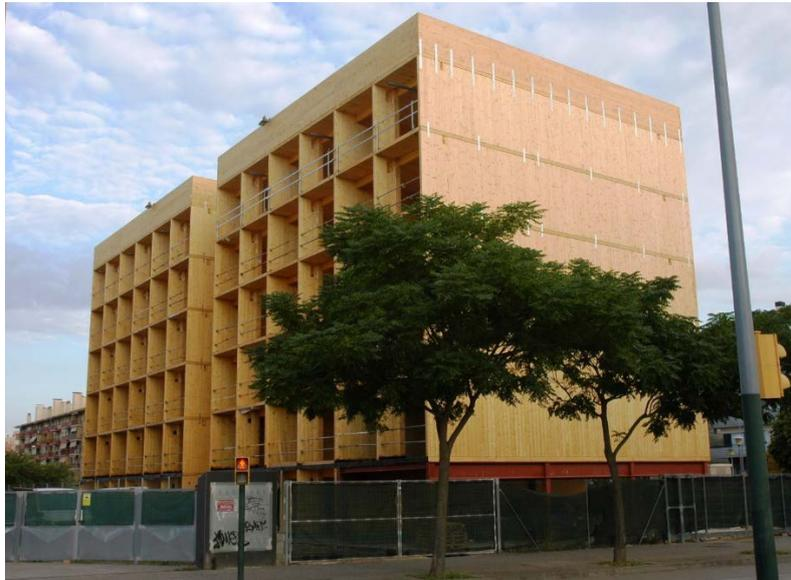
*Figura 4-14. Ejemplo de edificio con estructura de láminas de madera.
