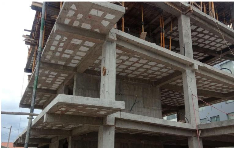
**Figura 36. Ejemplo de sistemas duales de pórticos y muros.**
