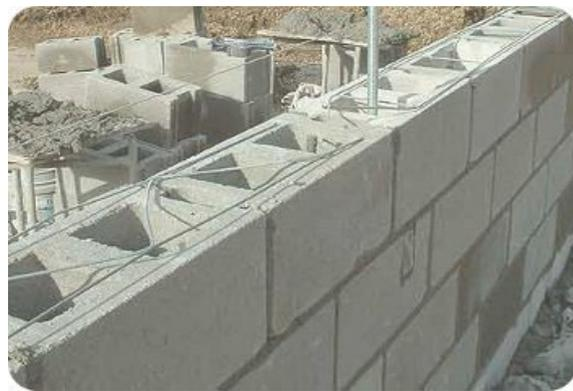
Figura 21. Imágenes de muros de fábrica armada.
