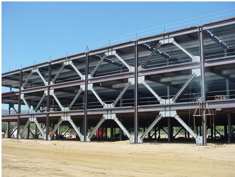
**Figura 45. Ejemplo de estructura de acero con pórticos arriostrados.**
