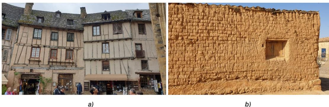
Figura 11.a) Ejemplo de edificio con muros de tapia y b) Ejemplo de edificio con ladrillos de adobe.
