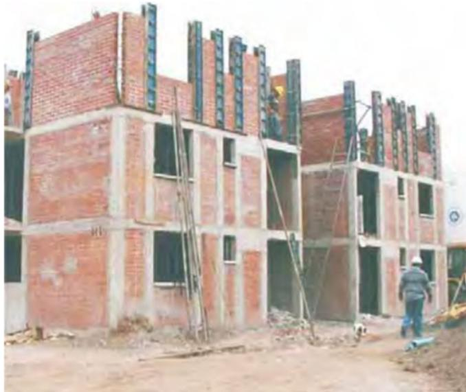
**Figura 23. Ejemplo de muro reforzados globalmente.**
