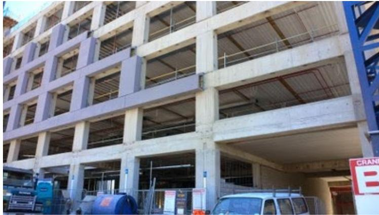
**Figura 25.** Ejemplo de edificio con pórticos de hormigón resistentes a momentos.
