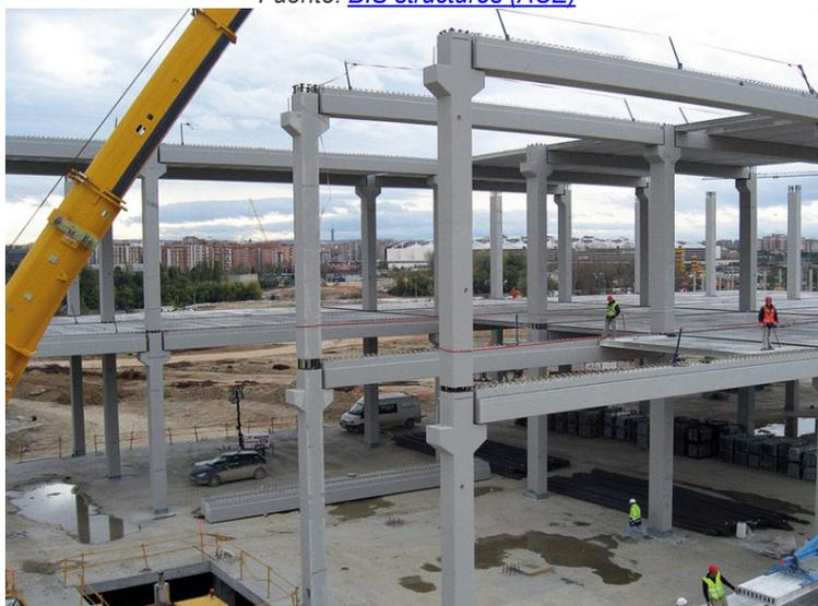
**Figura 41. Ejemplo de estructura de pórticos prefabricados.**
