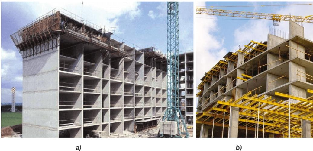
**Figura 27. Ejemplos de edificios con muros estructurales de hormigón.**
