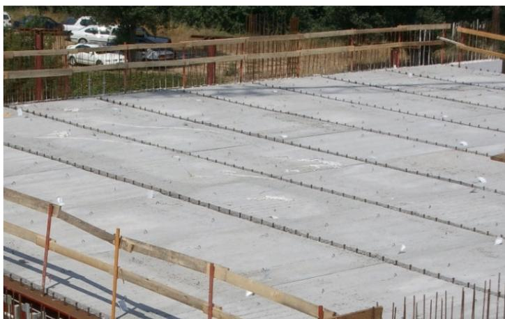
**Figura 52. Ejemplo de viga mixta después de colocar las placas de hormigón a falta de colocar una capa de hormigón in situ.**
