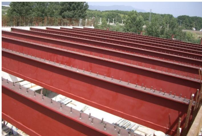
**Figura 51. Ejemplo de viga mixta antes de colocar las placas de hormigón. Se pueden observar los conectores para la unión con la capa de hormigón.**
