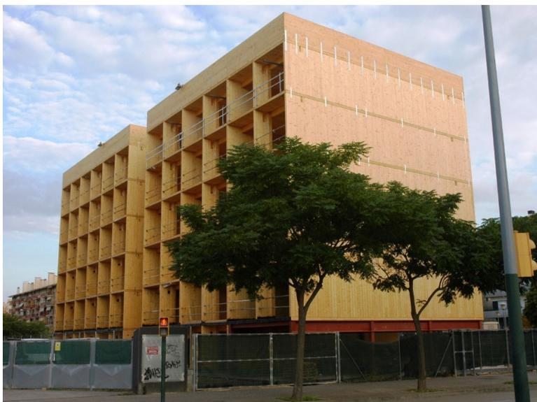
**Figura 58. Ejemplo de estructura con láminas de madera.**
