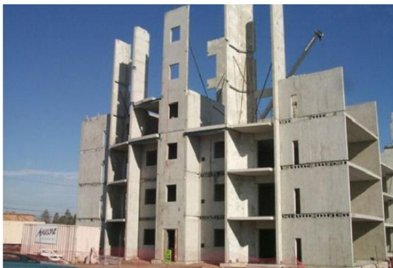
**Figura 38. Ejemplo de muros y forjados prefabricados.**
