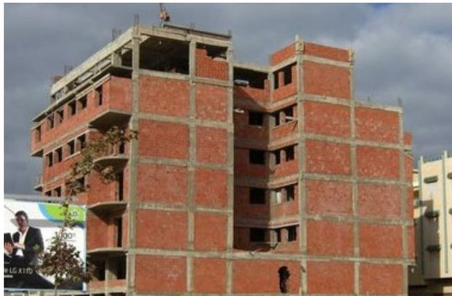
Figura 29. Pórticos regulares de hormigón con relleno de fábrica.
