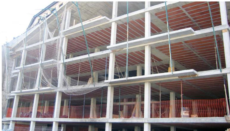
**Figura 32. Ejemplo de edificio de jácenas planas y forjados unidireccionales.**
