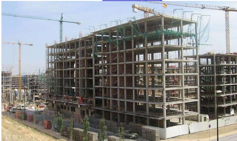
**Figura 34. Losas planas sobre pilares.**
