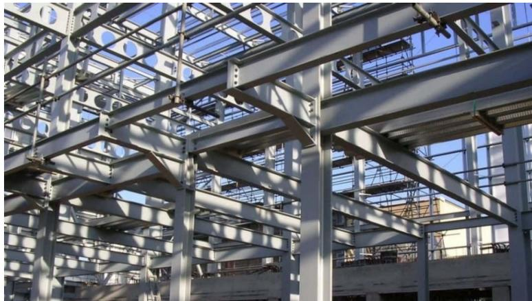
Figura 43. Ejemplo de pórticos de acero con nudos rígidos.
