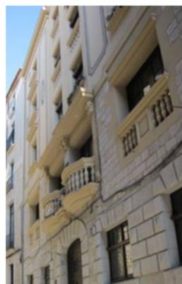
**Figura 4: Edificio típico con muros de carga de piedra tallada.**
