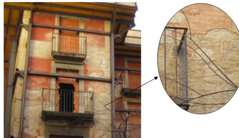
**Figura 3: Edificio de muros de carga de piedra.**
