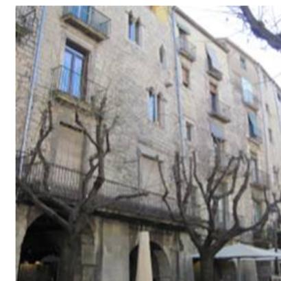
**Figura 5: Prototipo de edificio de altura media con muros portantes de piedra labrada.**
