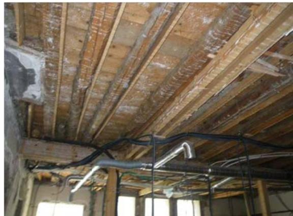
**Figura 13 - interior de un edificio en restauración en Luchon. Los trabajos conservan las vigas de madera.**
