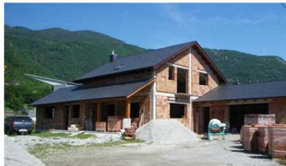
**Figura 15 - casa unifamiliar con sistema portante de pórticos de hormigón y muros de relleno de mampostería (Cierp-Gaud).**
