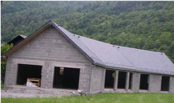
**Figura 16 - casa aislada en construcción, de muros portantes de mampostería. Presenta aberturas en todas las fachadas y forma irregular en planta.**
