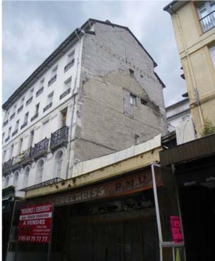
**Figura 10 - edificio en el centro de Luchon (muro portante de mampostería de piedra) con dos plantas añadidas.**
