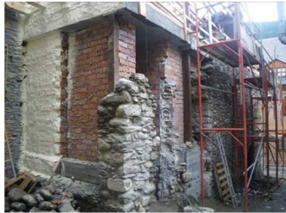
**Figura 11 - reforma completa de casa típica en el centro del núcleo de Salardú (Val d'Aran). Mezcla de diferentes materiales: mampostería de ladrillo y piedras (revestimiento exterior, ornamental), planchas de hormigón y pilares metálicos.**
