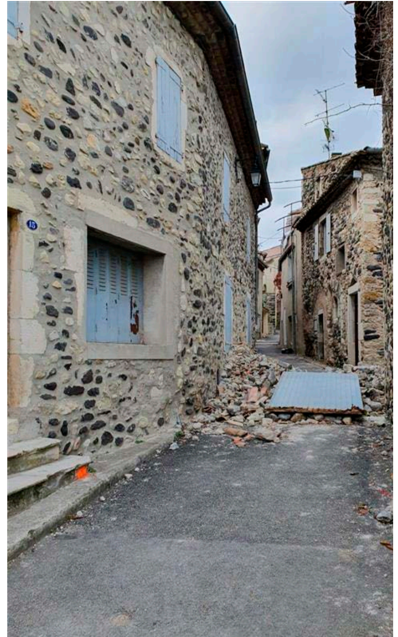
Foto : © BRGM – Carrer de Le Teil després del terratrèmol de l'11 de novembre de 2019
